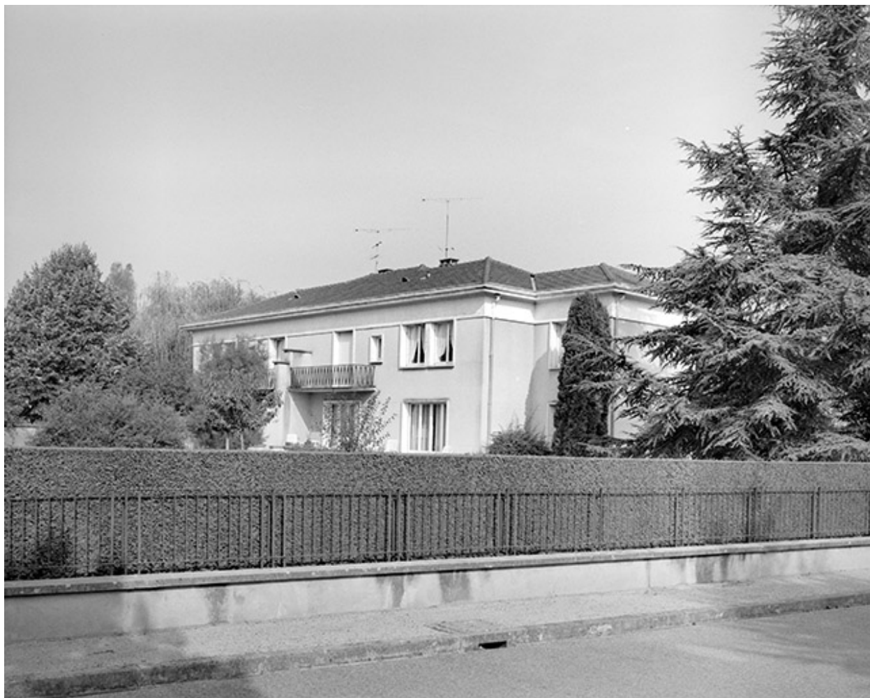
Façade postérieure vue depuis la rue.
