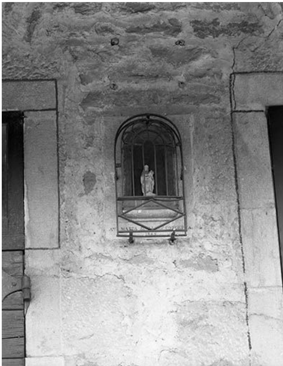
La niche ornant la façade antérieure.
