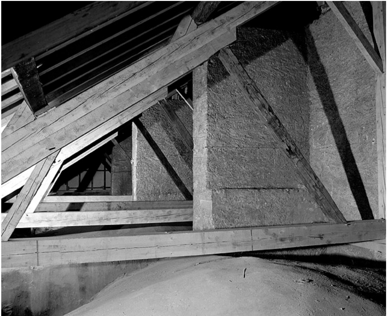
Murs-boutants du vaisseau central dans le comble du collatéral sud.
