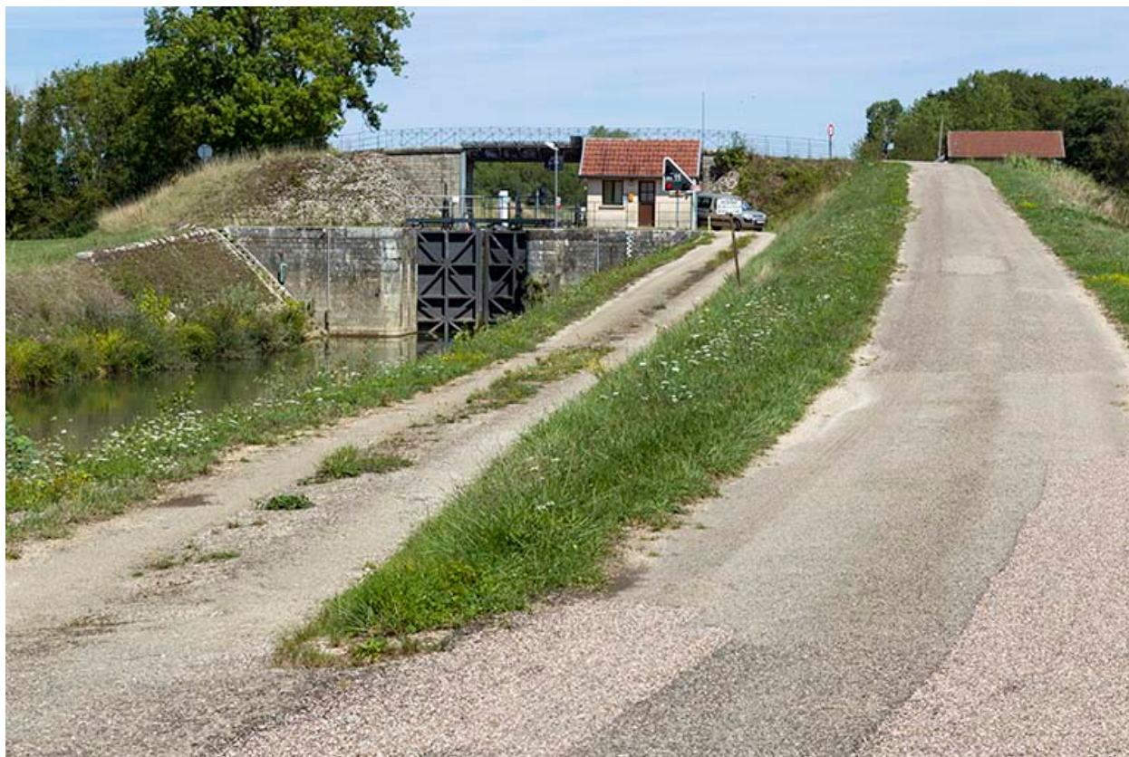
Vue du site d'écluse depuis l'aval.
