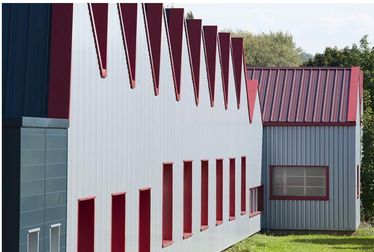
Détail du bardage de la façade sud.
