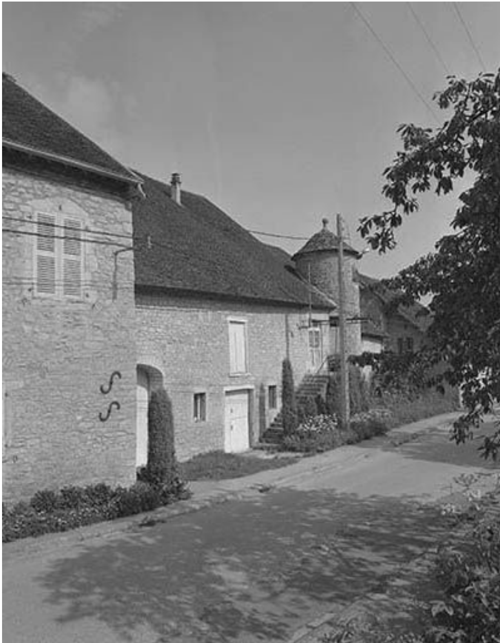
Façade sur rue, partie gauche.
