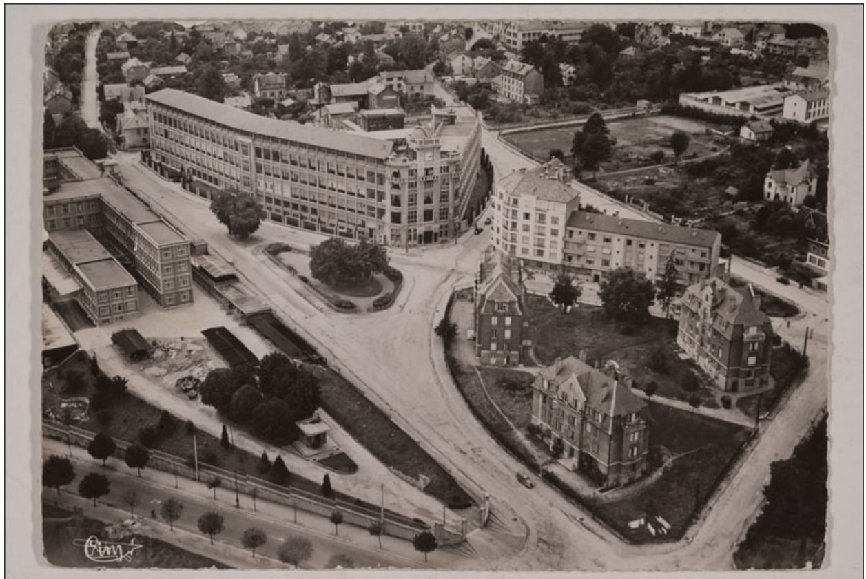
Besançon (Doubs). 11234 - Vue aérienne - L'Ecole d'Horlogerie [depuis l'est], entre 1945 et 1953.
