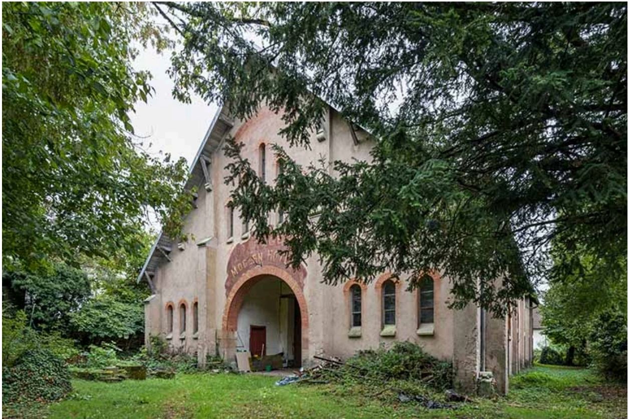
Mur-pignon nord, vue de trois quarts.
