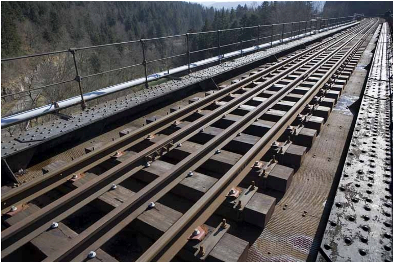
La voie sur la travée métallique, depuis le côté La Cluse.
