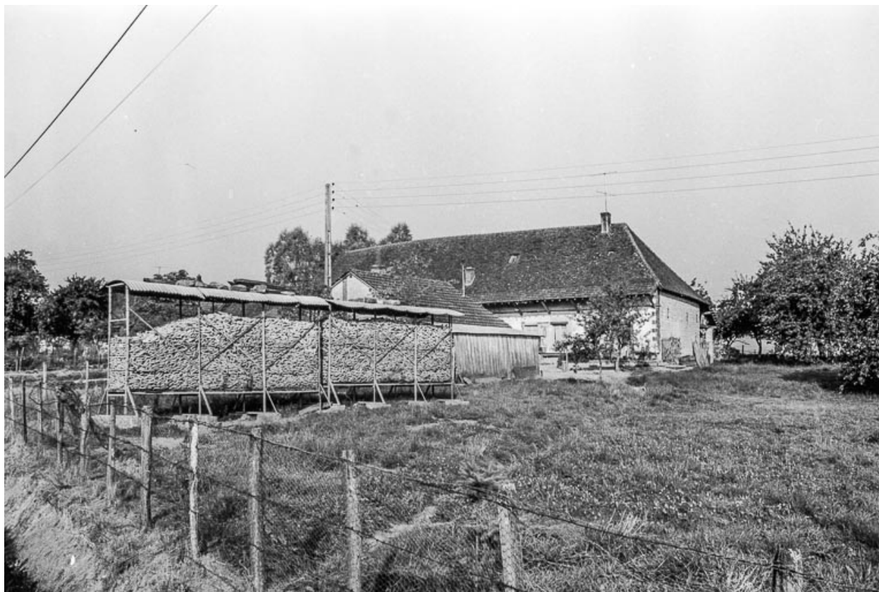
Ferme cadastrée 1956 A1 168 : façade antérieure.
