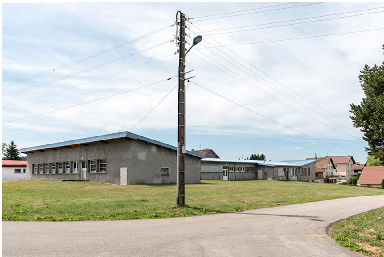
Façades postérieure et latérale droite.
