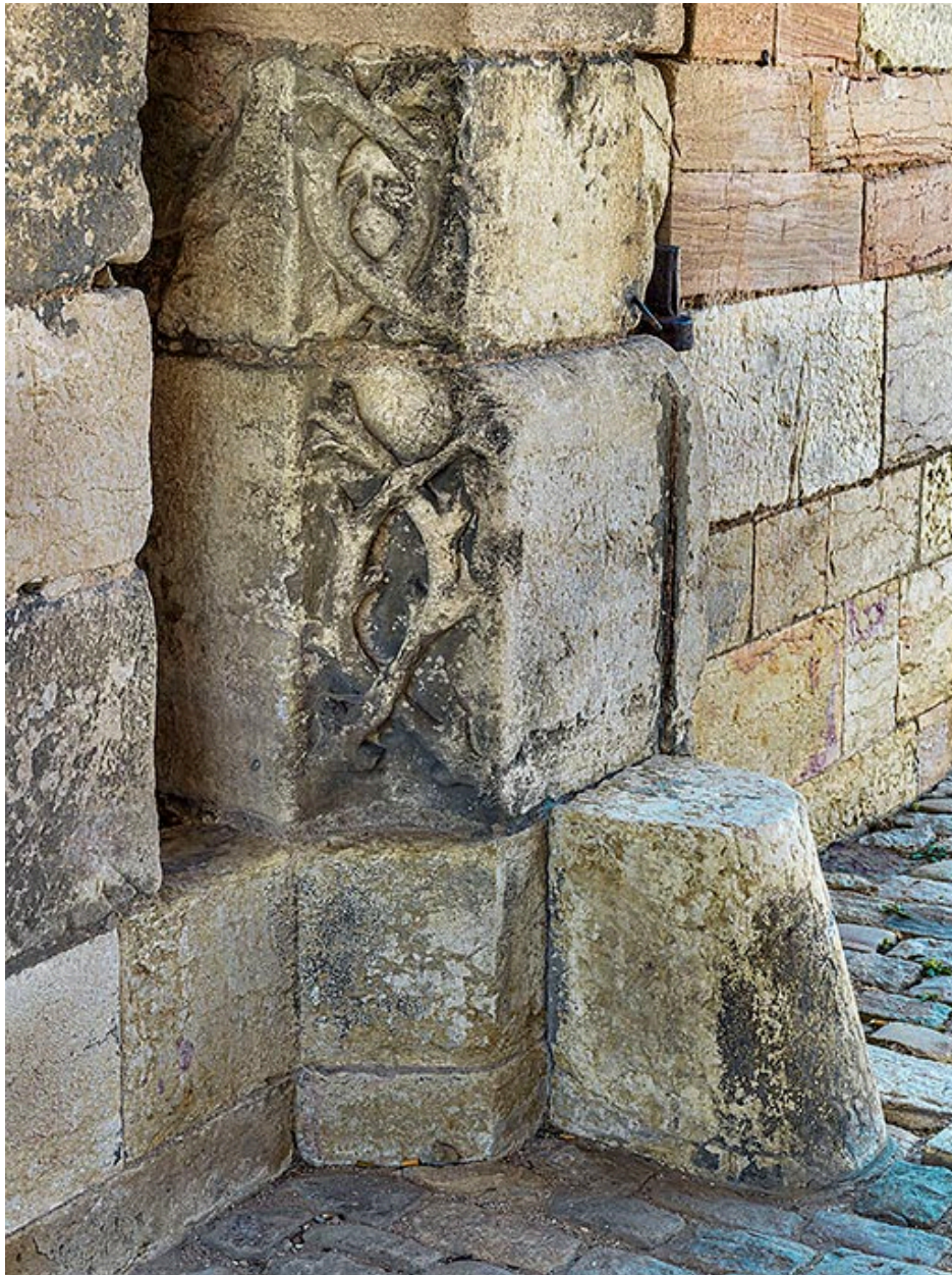
Détail sur la partie basse du chambranle.
