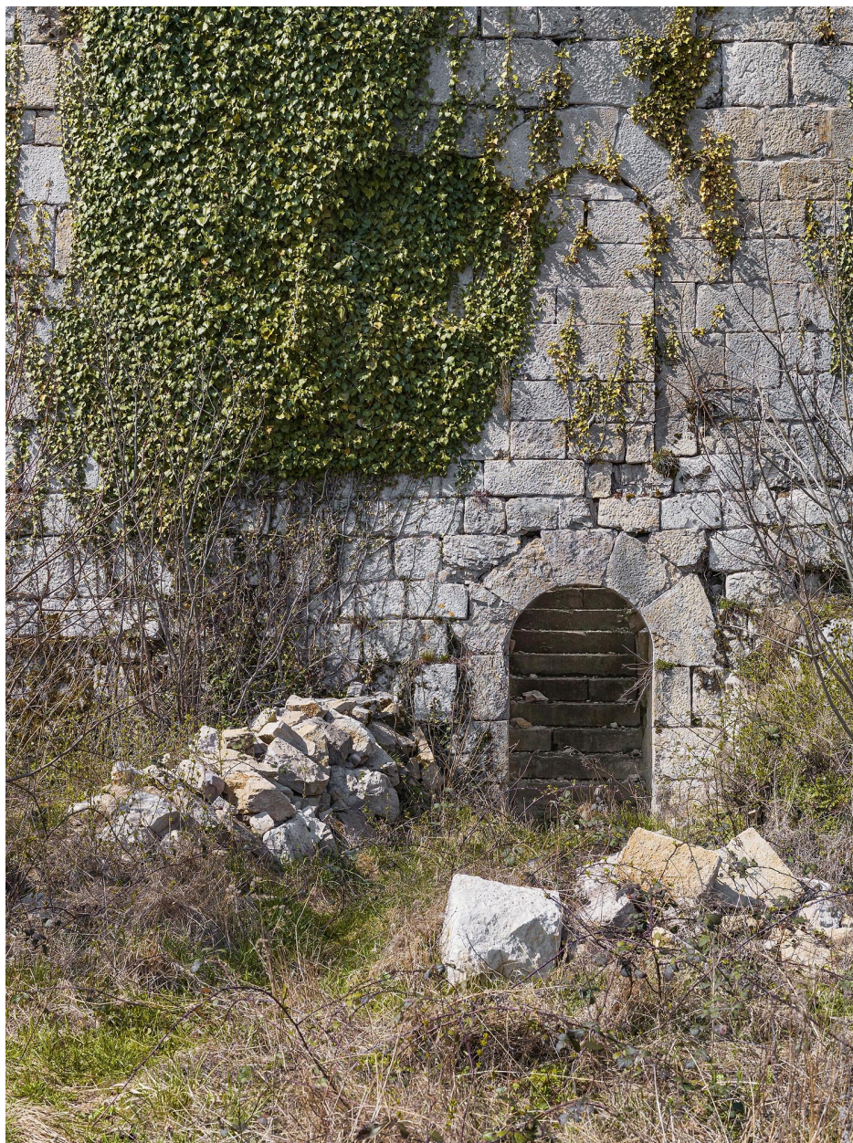
Porte d'accès à la fausse braie.
