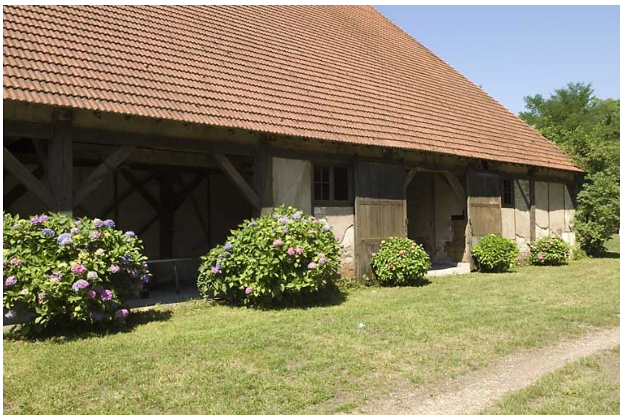
Extrémité nord de la halle à charbon.
