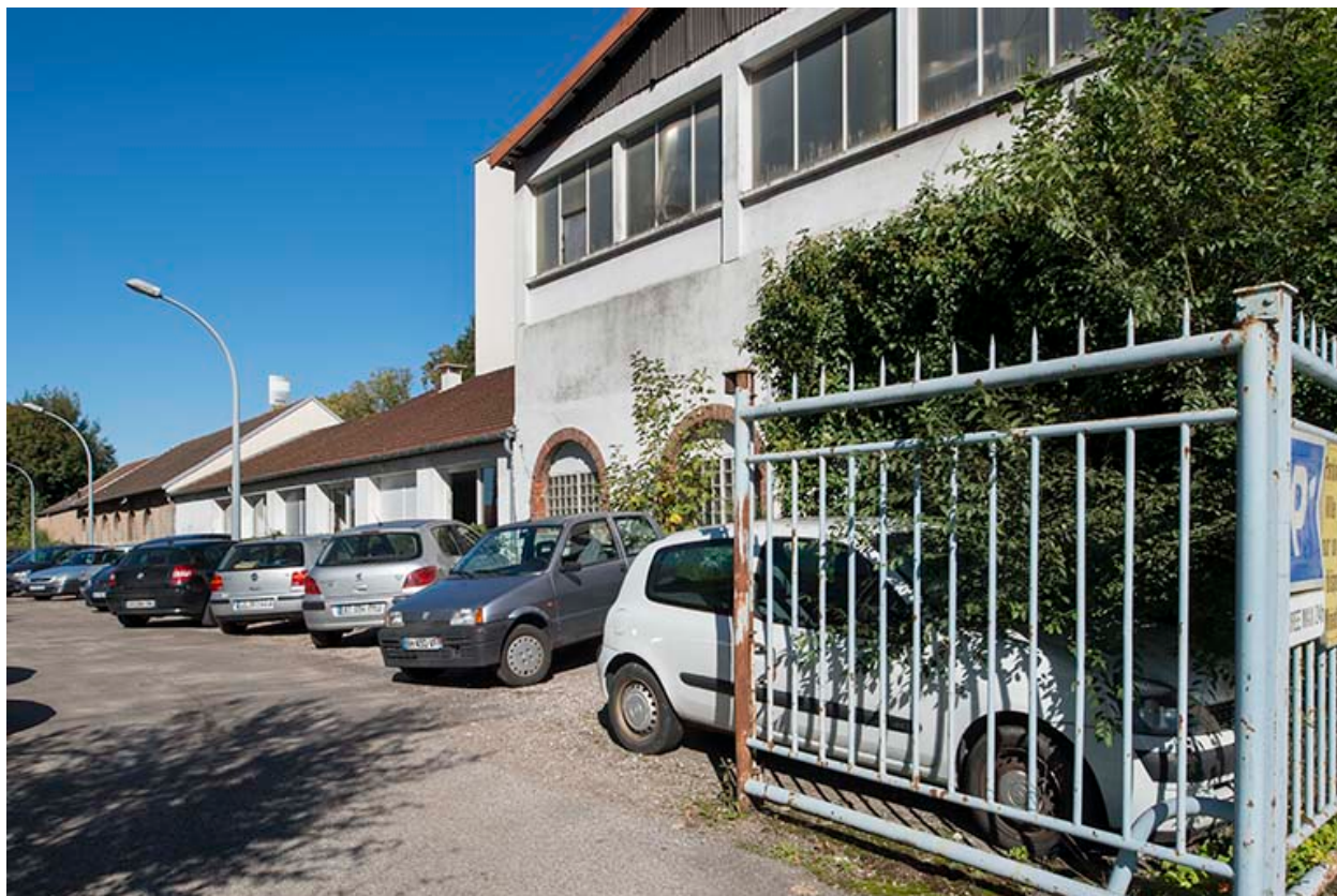
Ateliers de la fonderie. Façades ouest.
