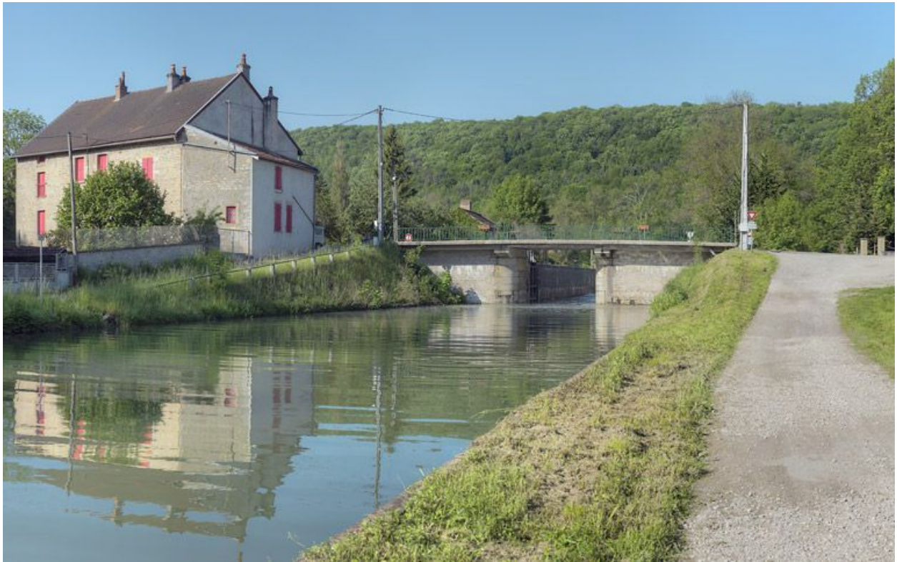
Le pont vu d'aval.
