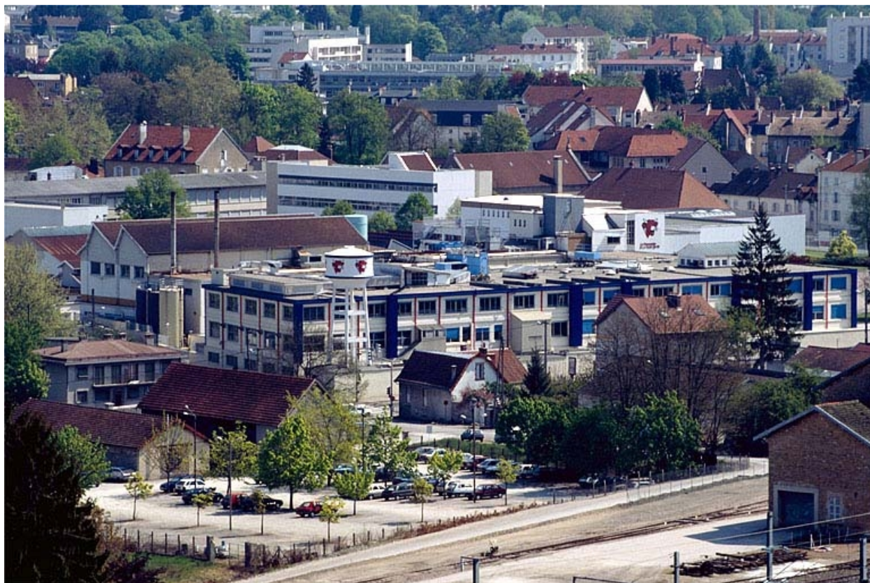
Vue d'ensemble depuis la côte de Montciel.
