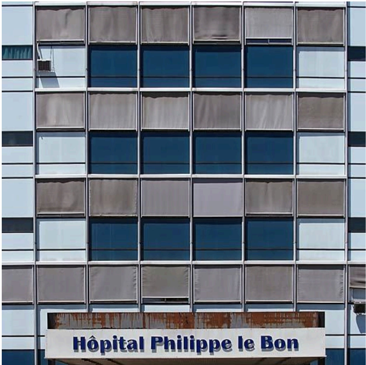
Bâtiment principal, détail de la façade.
