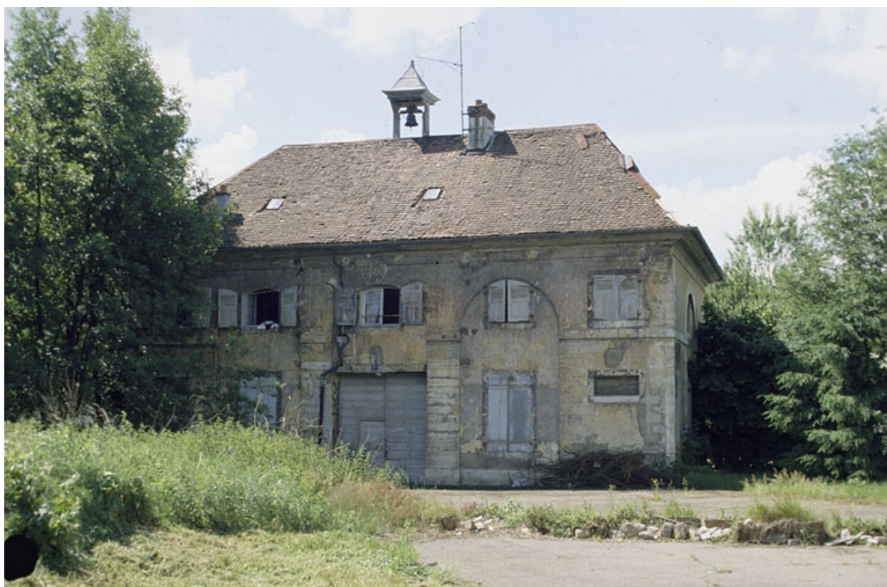
Façade postérieure des communs nord.
