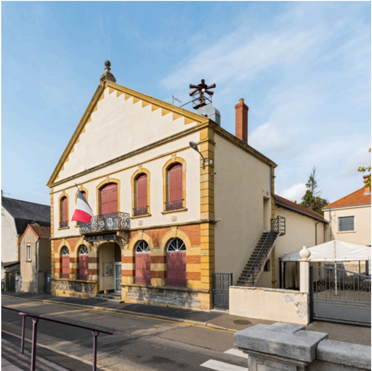
Vue d'ensemble, depuis le sud.
