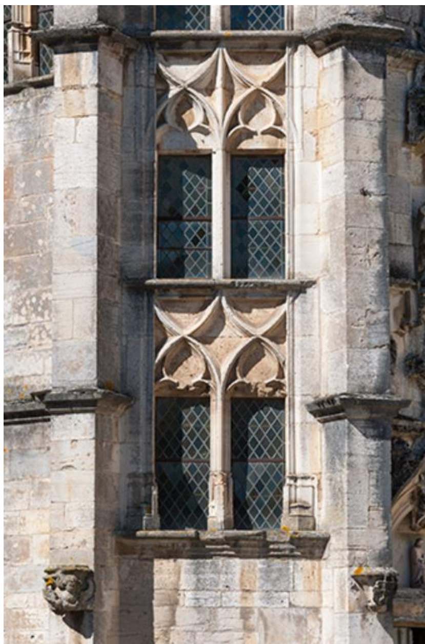
Détail des baies de la tour d'escalier
