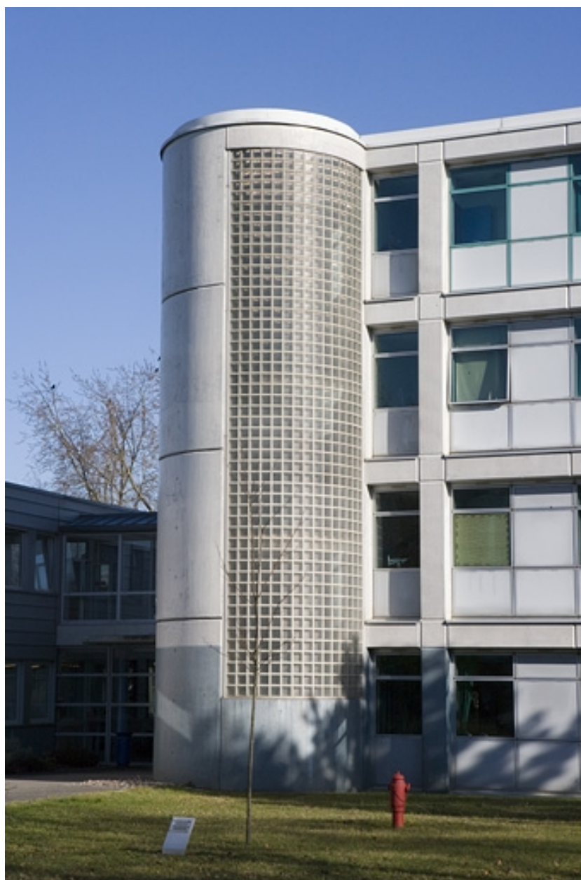
Bâtiment B. Détail de la travée d'escalier.
