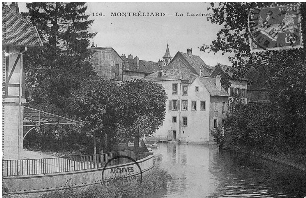
Montbéliard. La Luzine [vue du jardin de la maison], avant 1913.
