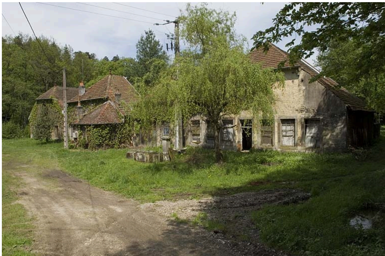
Façades antérieures depuis le sud.
