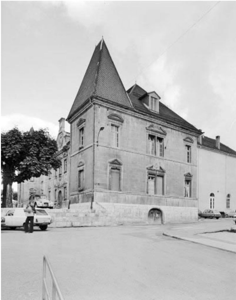
Façade latérale droite.
