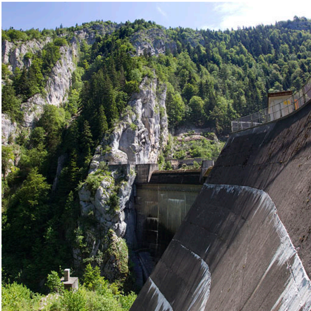
Barrage du Châtelot : ancrage rive droite.
