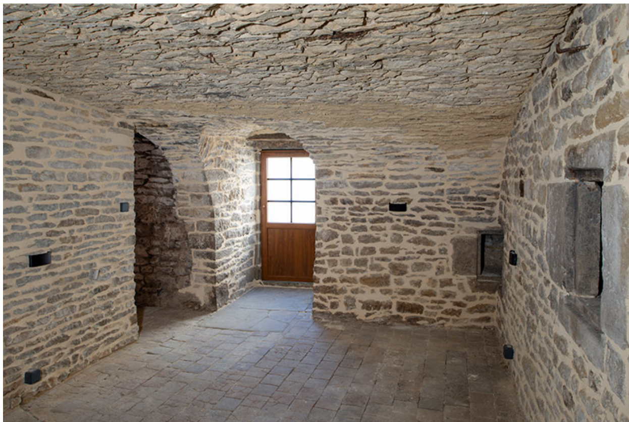
Le cellier du rez-de-chaussée, en direction du nord.
