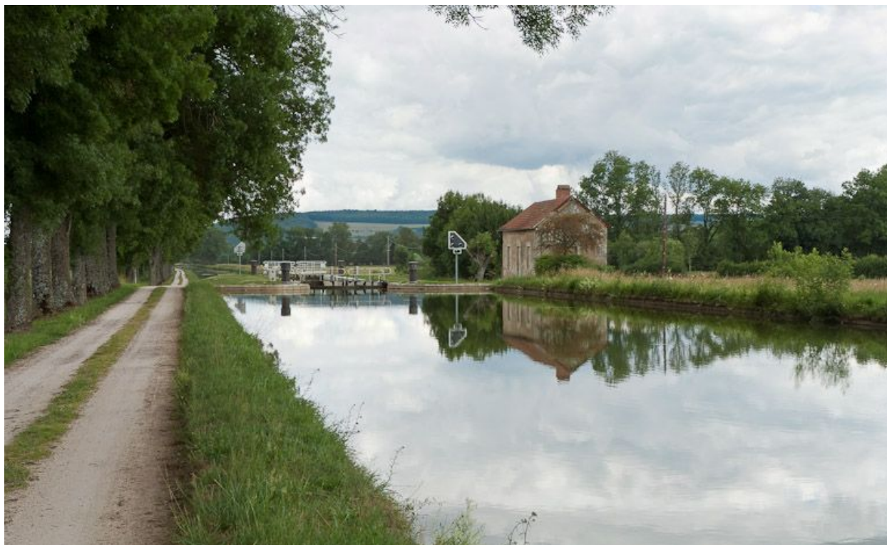
Vue d'ensemble du site d'écluse.
