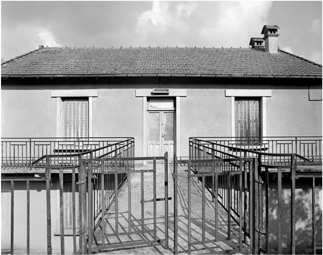
Façade antérieure du logement d'ouvriers.
