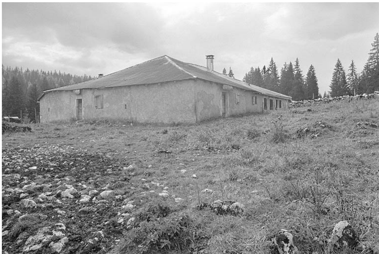
Angle nord du bâtiment.
