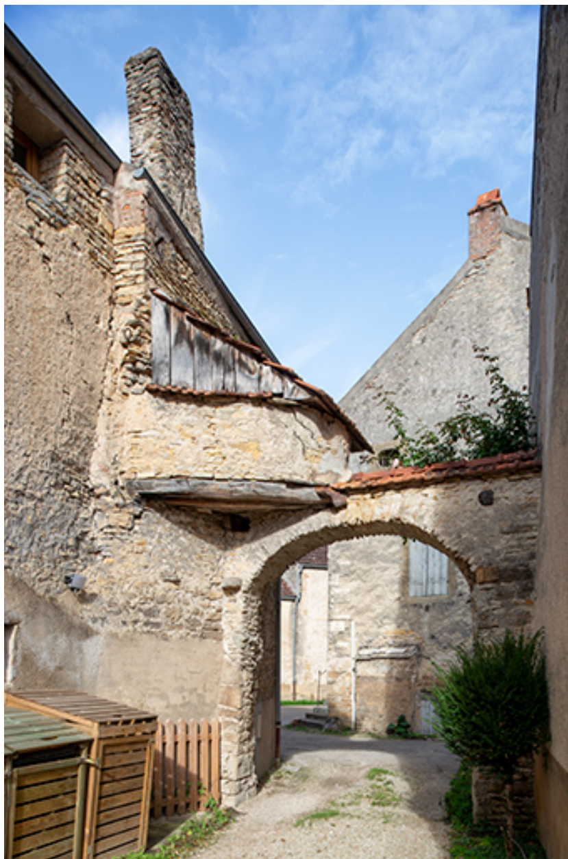
La porte charretière avec le four, depuis la cour.
