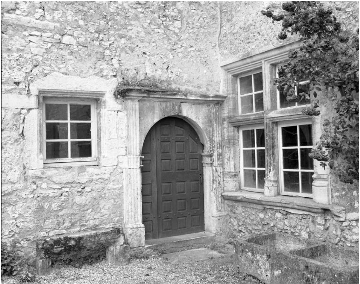
Partie gauche du couvent : bâtiment en fond de cour, détail de la porte d'entrée de l'escalier.
