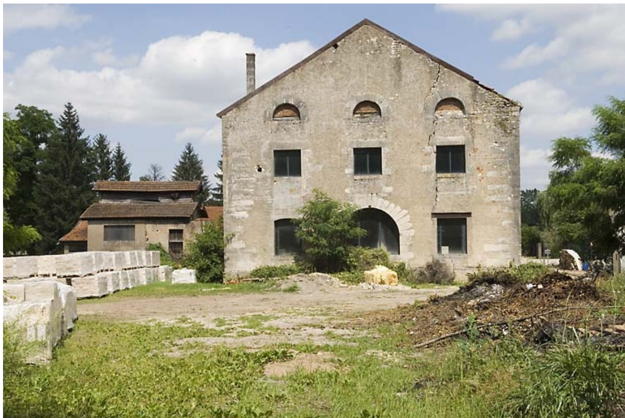
Pignon du bâtiment du haut fourneau ouest.
