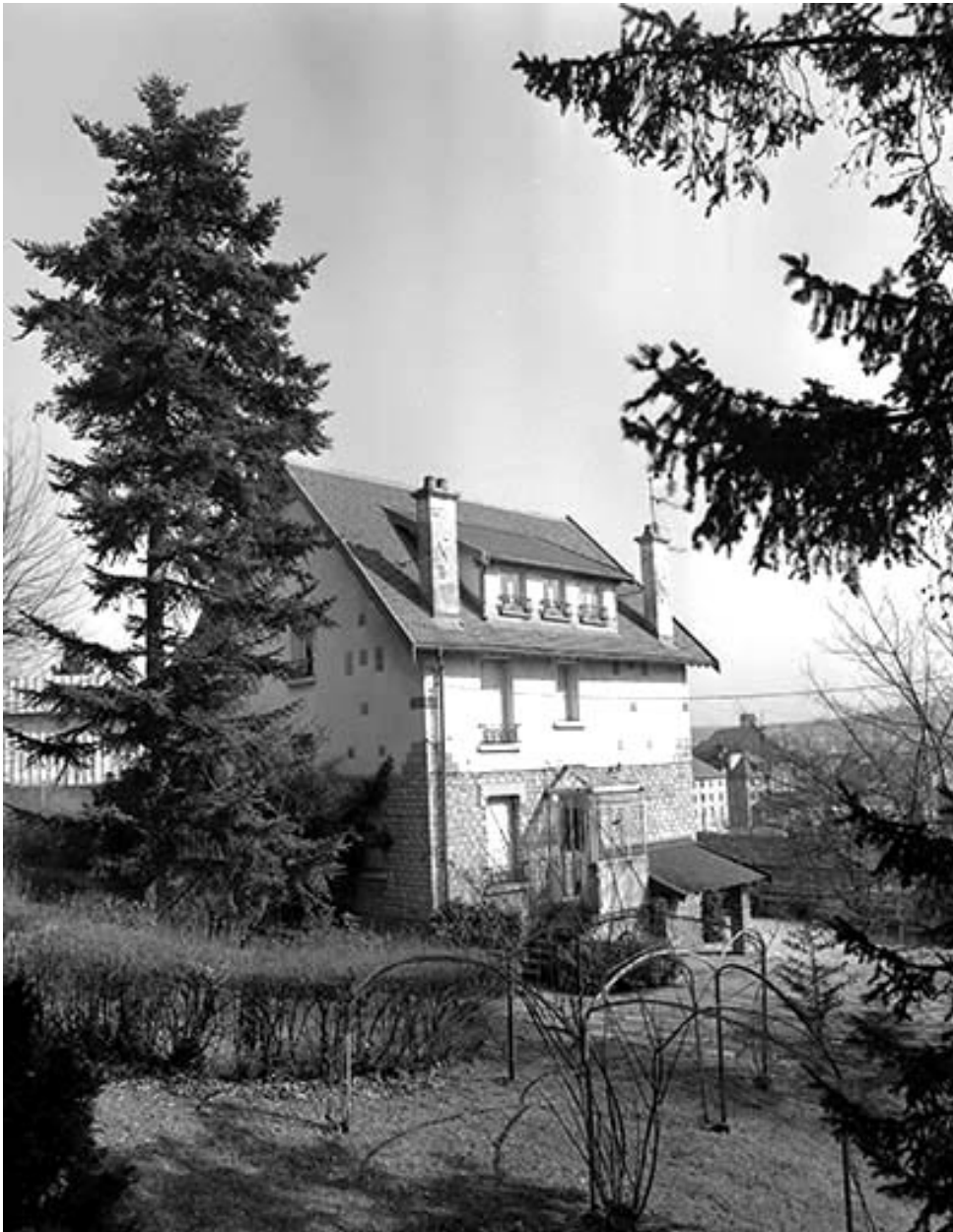
Façade antérieure du logement patronal, de trois quarts gauche.
