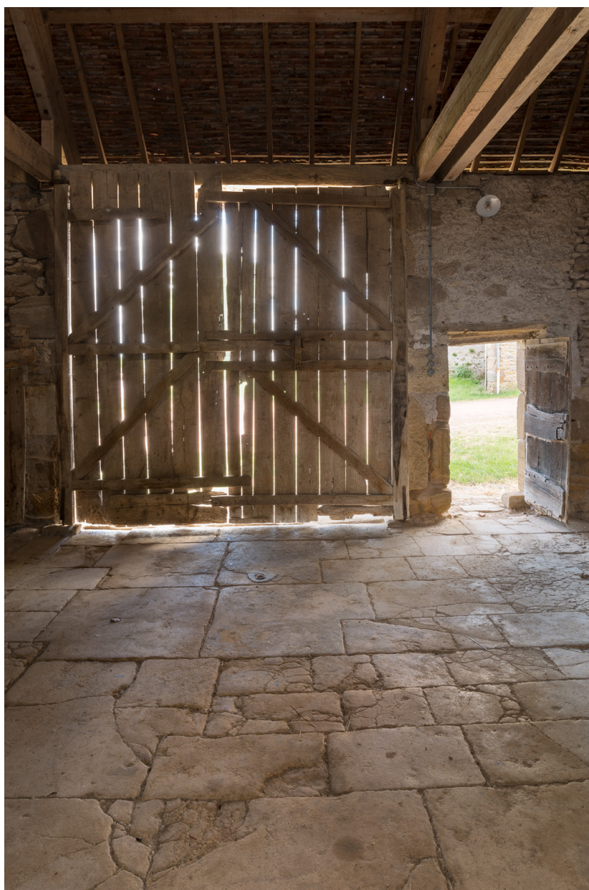
Bâtiment agricole. Vue intérieure de la remise.
