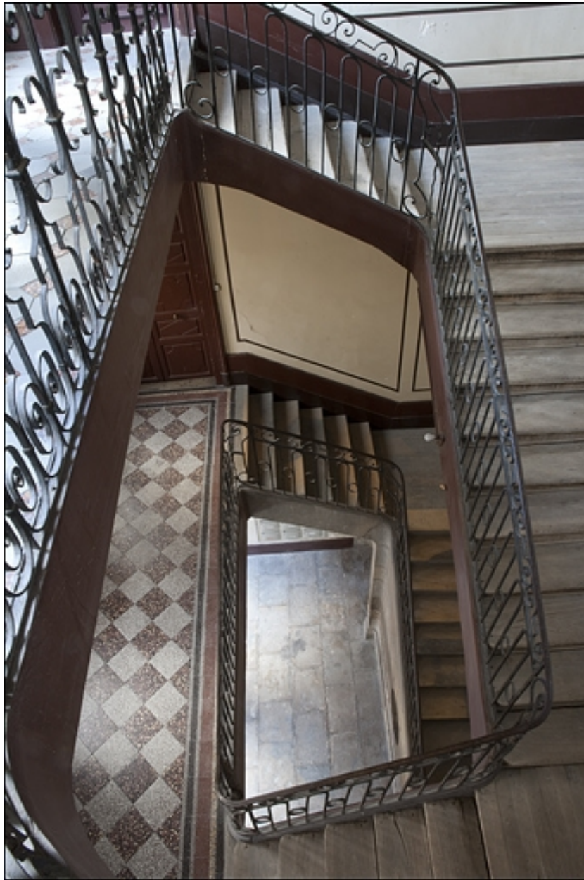
Vue d'ensemble de l'escalier principal depuis le dernier palier.
