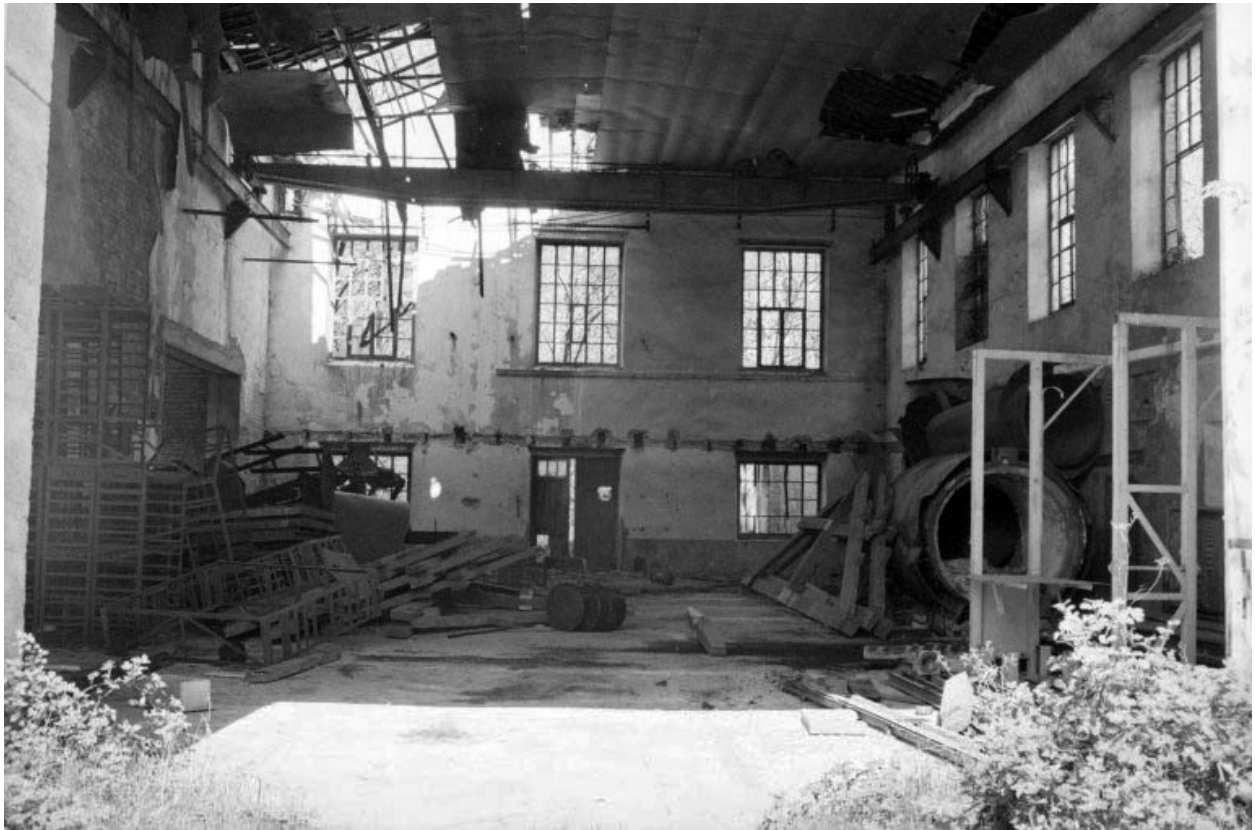
Forge Neuve. Centrale électrique : intérieur de la salle des machines H (ancien bâtiment du haut-fourneau).
