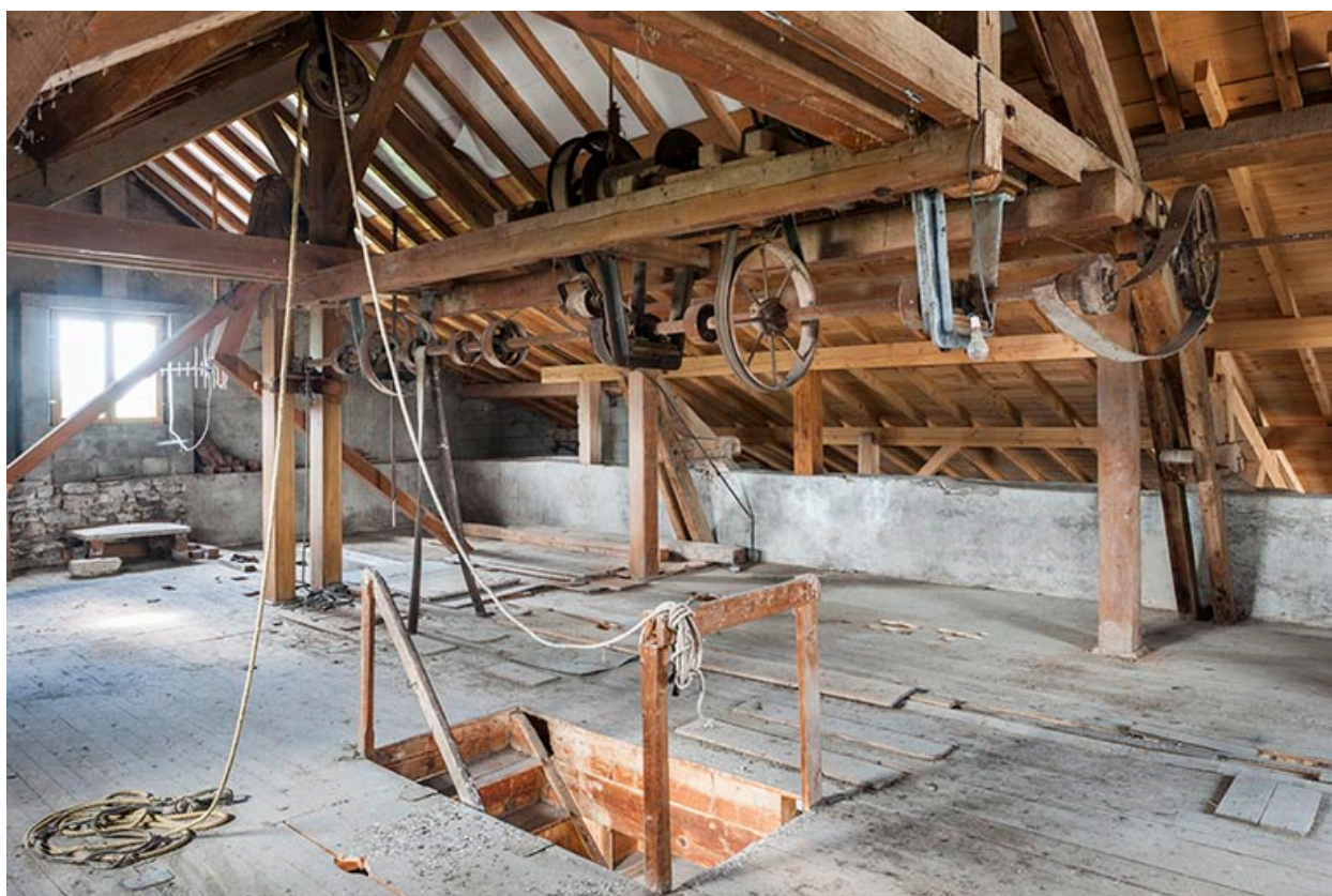
Etage en surcroît. Vue d'ensemble.
