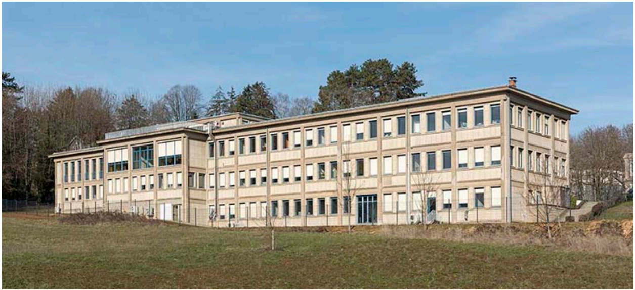
Façades postérieure et latérale gauche.
