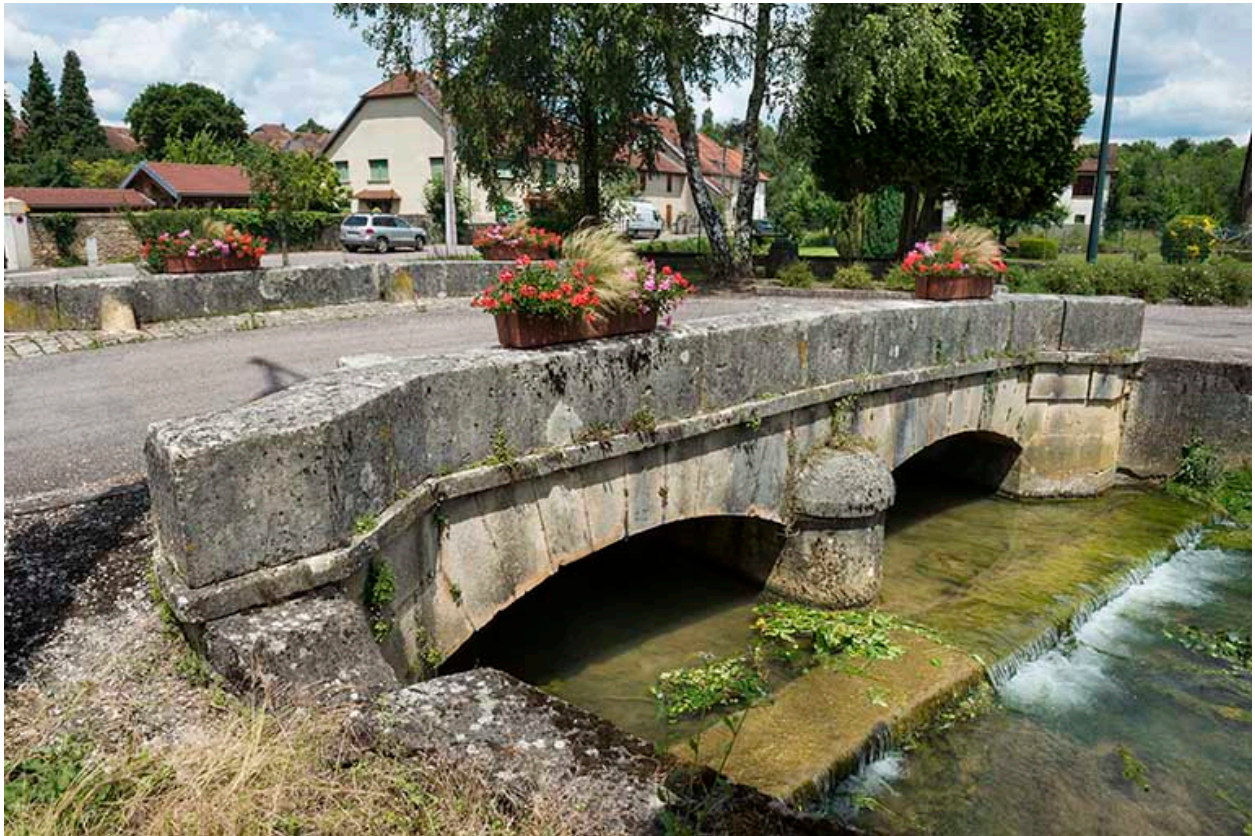
Face sud, vue depuis l'ouest.
