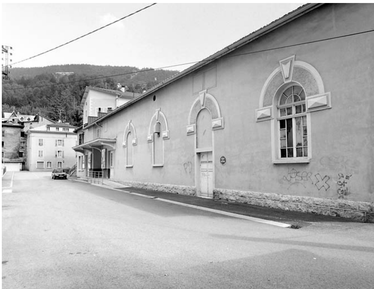
Elévation antérieure, de trois quarts droite.
