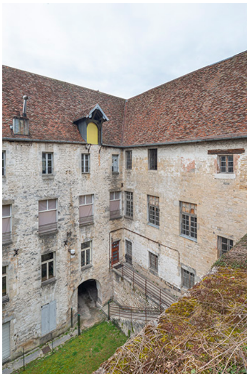
Partie nord des bâtiments sur cour.
