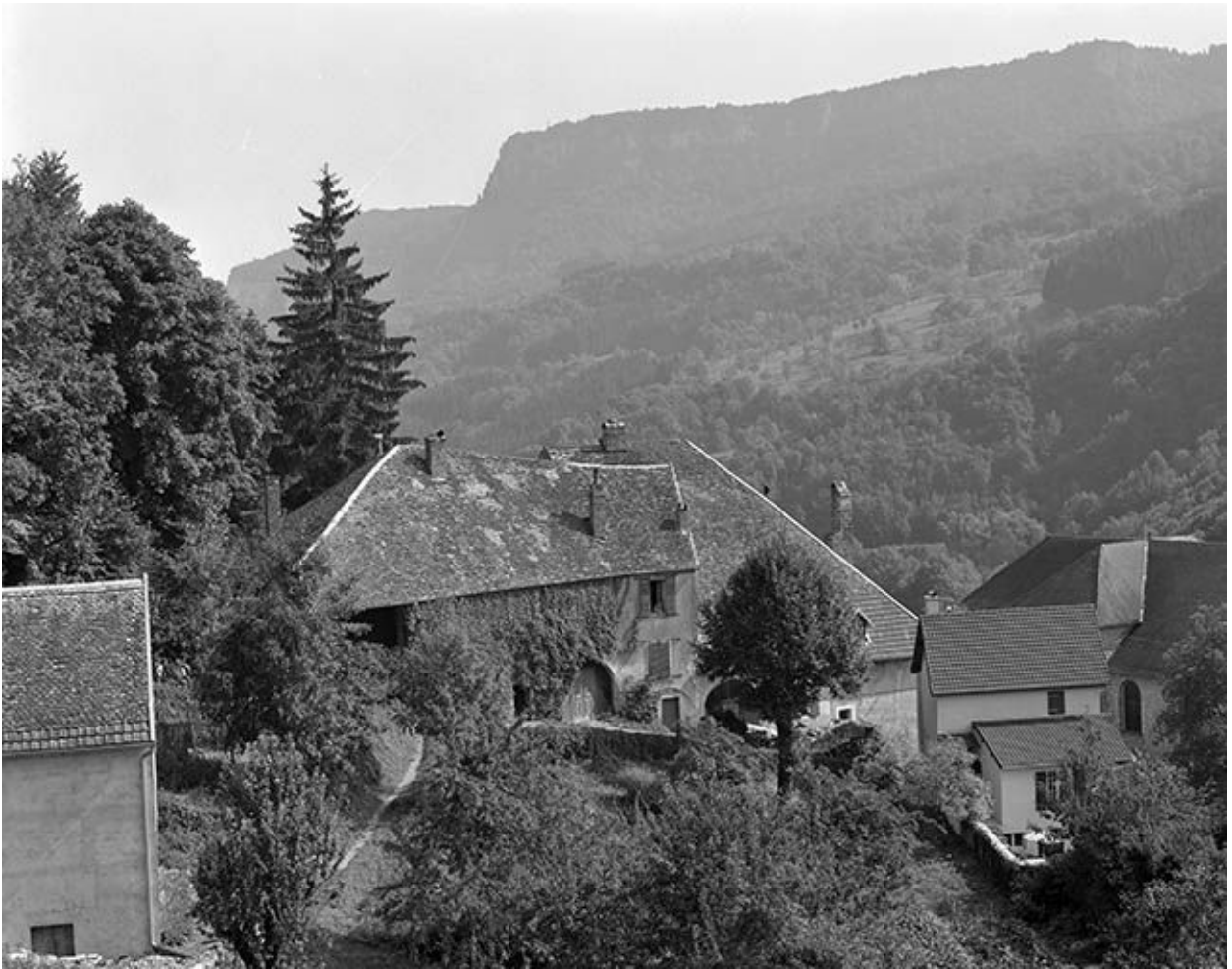
Maison située rue de l'Eglise, cadastrée 1971 AC 99 : vue depuis le sentier de la Planche.
