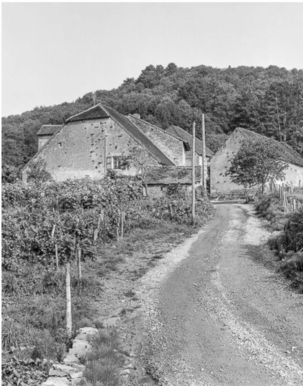
Prieuré : vue d'ensemble depuis le chemin.
