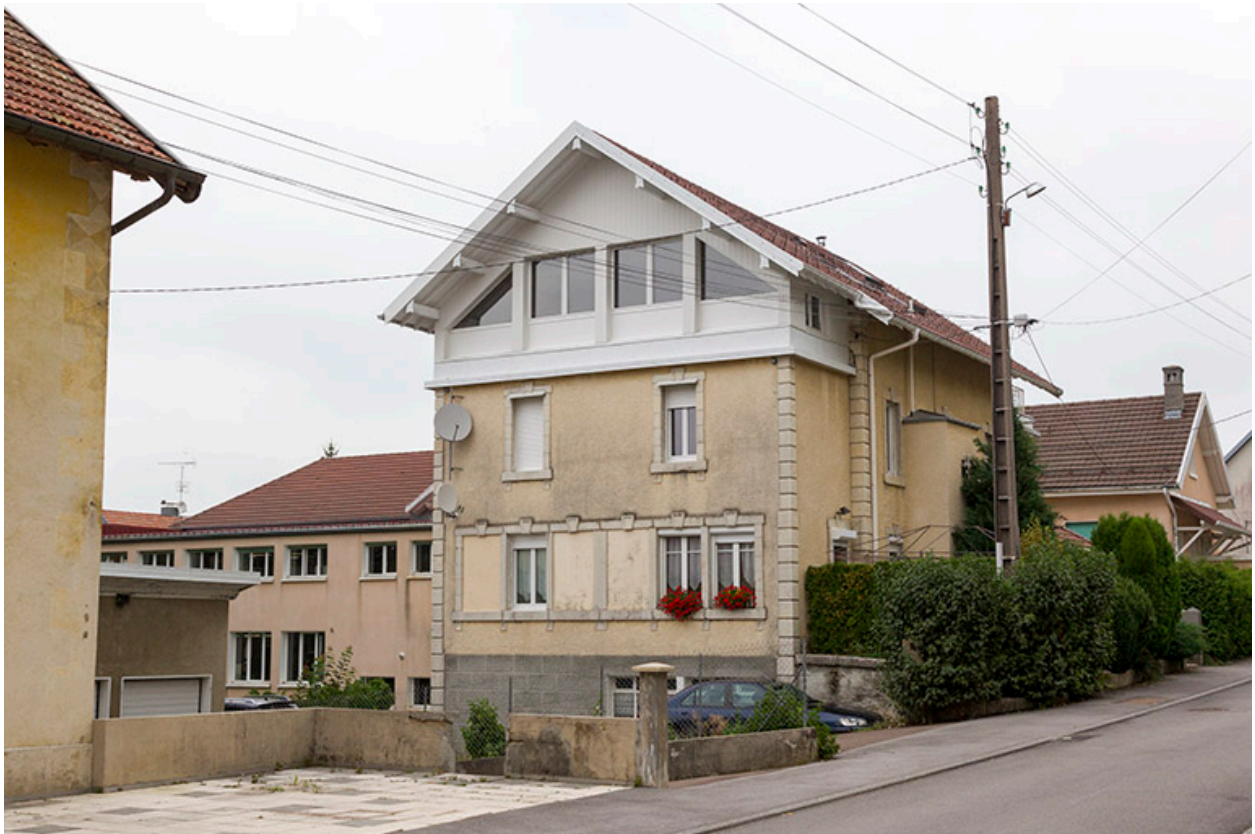
Maison : façades antérieure et latérale gauche.
