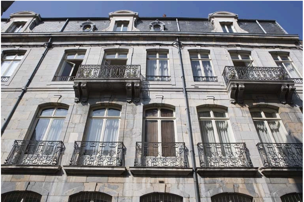
Façade antérieure du logis principal à partir du premier étage, de face.
