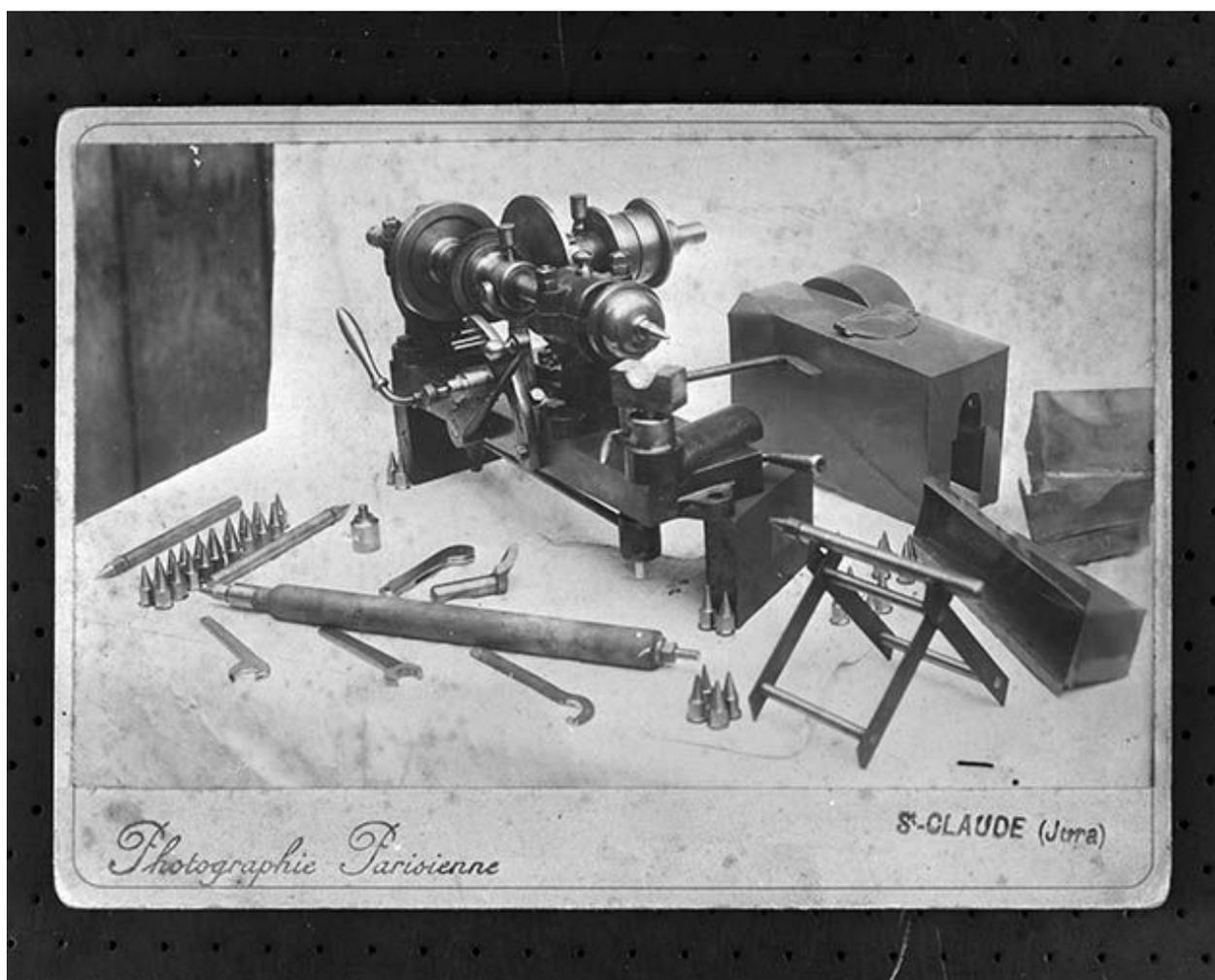
Exemple de machine à débruter du constructeur mécanicien Léon Lizon.
