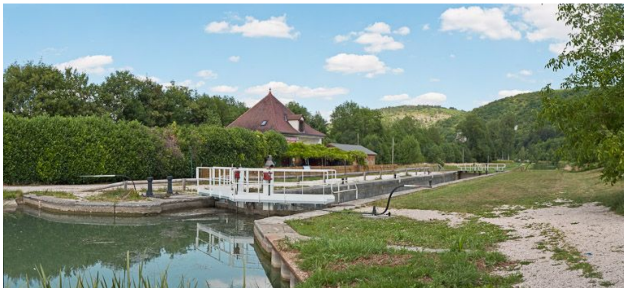
Vue d'ensemble du site d'écluse.
