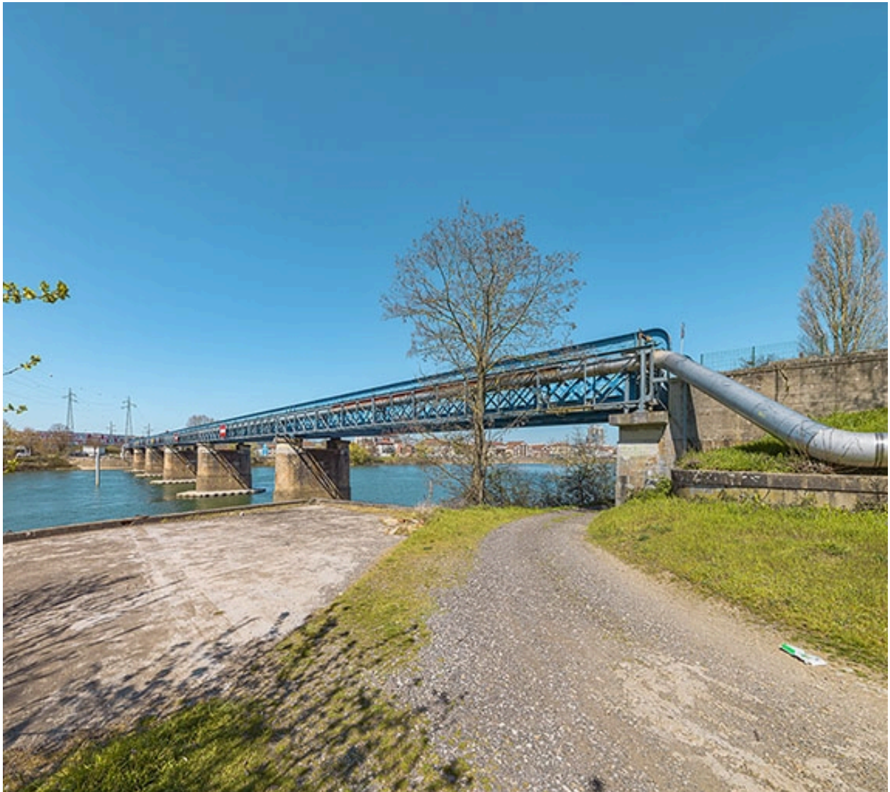
Vue d'ensemble du pont, depuis la rive gauche.
