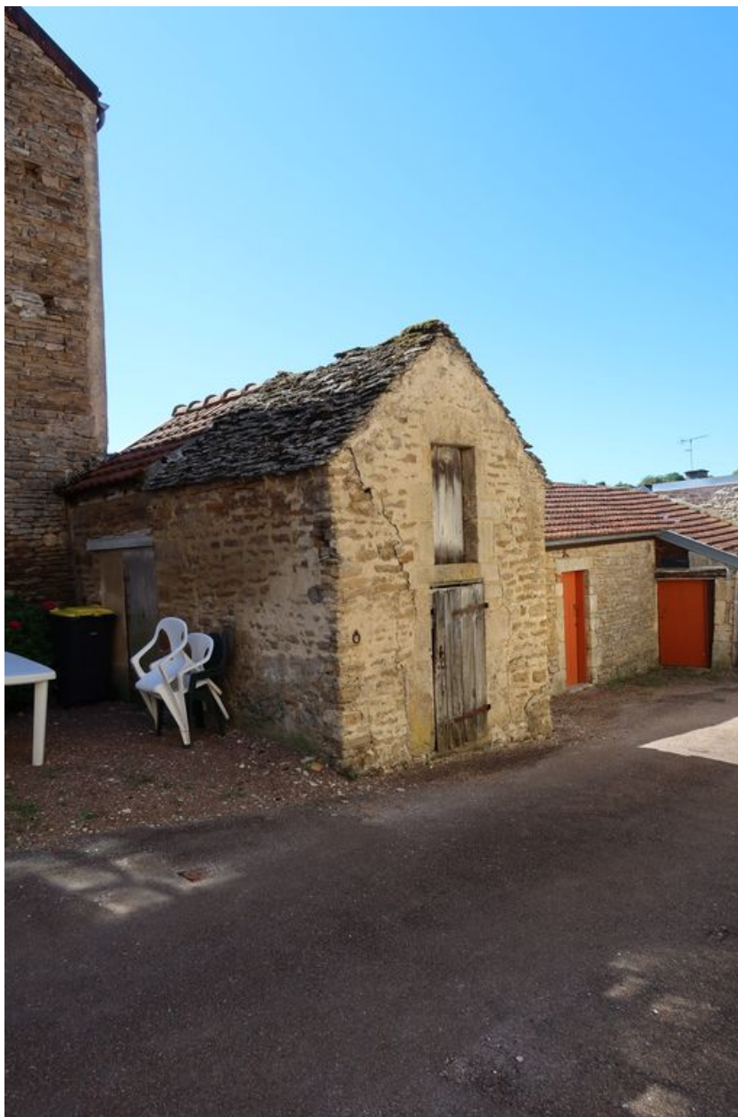
Vue du poulailler depuis le nord-ouest.
